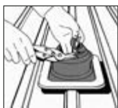
1. DEKTITE® an Rohr anpassen.
