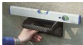
4. Steigeisen ausrichten.
