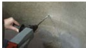
Einfache Montage – schnelle und sichere Verankerung: 1. Bohrloch erstellen.
