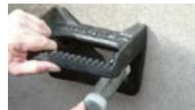
3. Steigeisenanker durch die Bohrung im Steigeisen im Durchsteckverfahren setzen.
