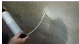
2. Bohrloch reinigen.
